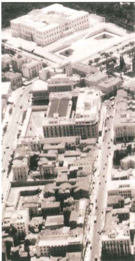
Αεροφωτογραφία του έτους 1934. Στο βάθος, τὰ ανάκτορα (μέγαρο τῆς Βουλῆς) μετὰ τὴν διαμόρφωση τοῦ μνημείου τοῦ Ἀγνώστου Στρατιώτου. Τὸ μέγαρο τοῦ Μετοχικοῦ Ταμείου Στρατοῦ στὸν χώρον τῶν βασιλικῶν σταύλων, ὑπὸ κατασκευήν.
